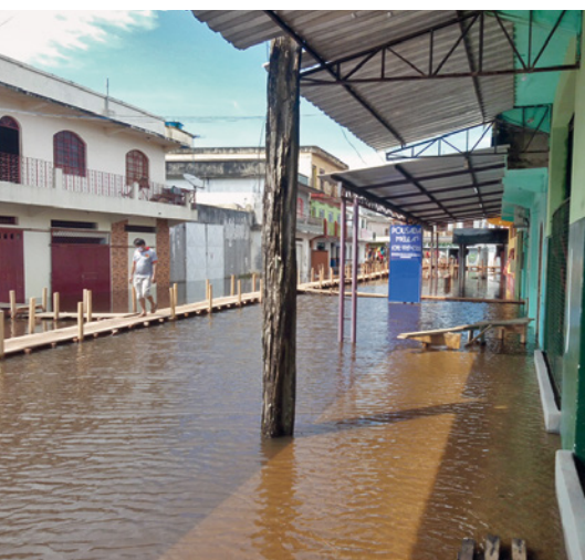
Überflutung in Itacoatiara: Über Holzstege kommt man noch knapp zu den Gebäuden.
