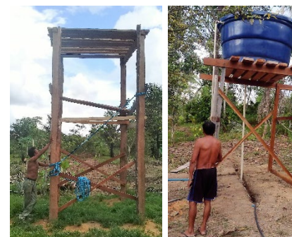
Gerüst für eine Bewässerungsanlage in Rodon, auf dem Festland, und fertige Anlage im Arari.
